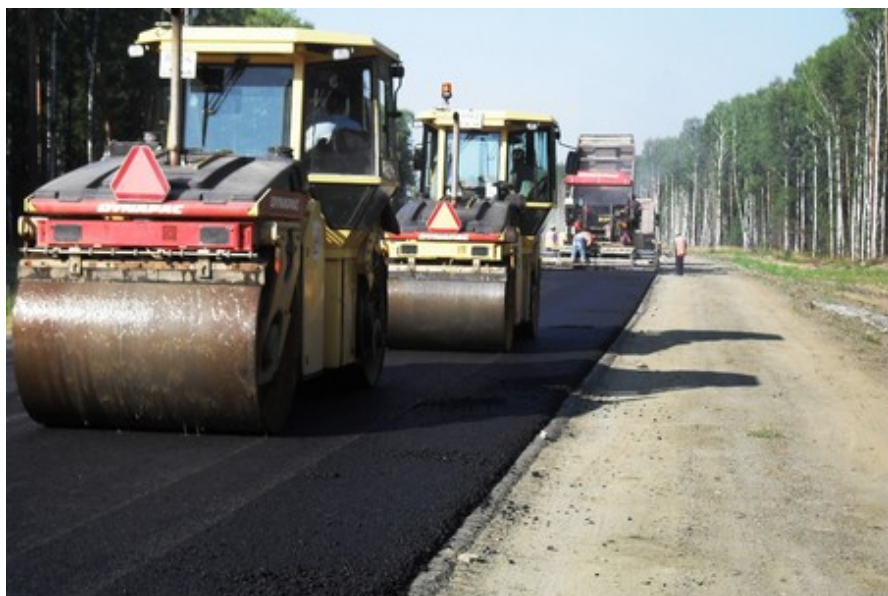
Укладка дорожного покрытия с модификатором в Екатеринбурге
